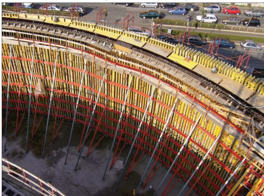
Veduta delle casseforme utilizzate per la realizzazione di una parete curva
