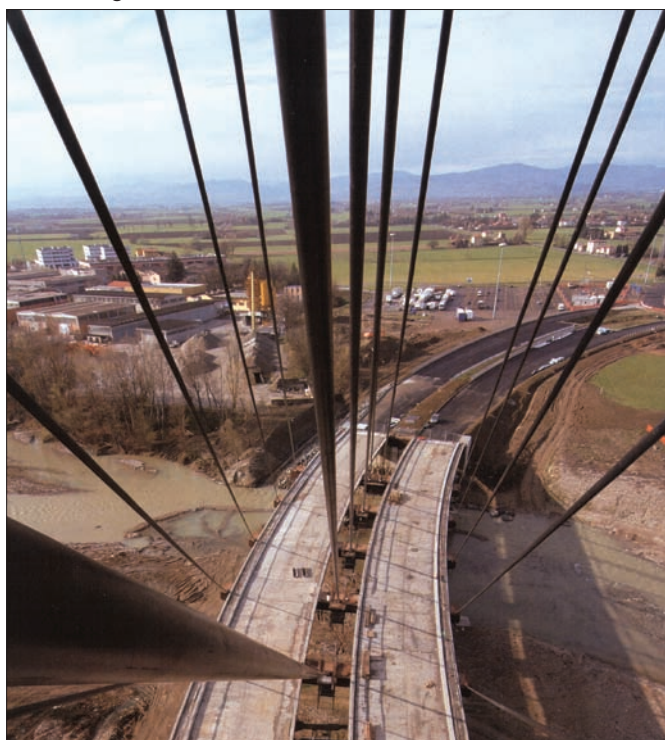
Fig. 5 - Vista dell'impalcato finito dal castello di ancoraggio degli stralli
