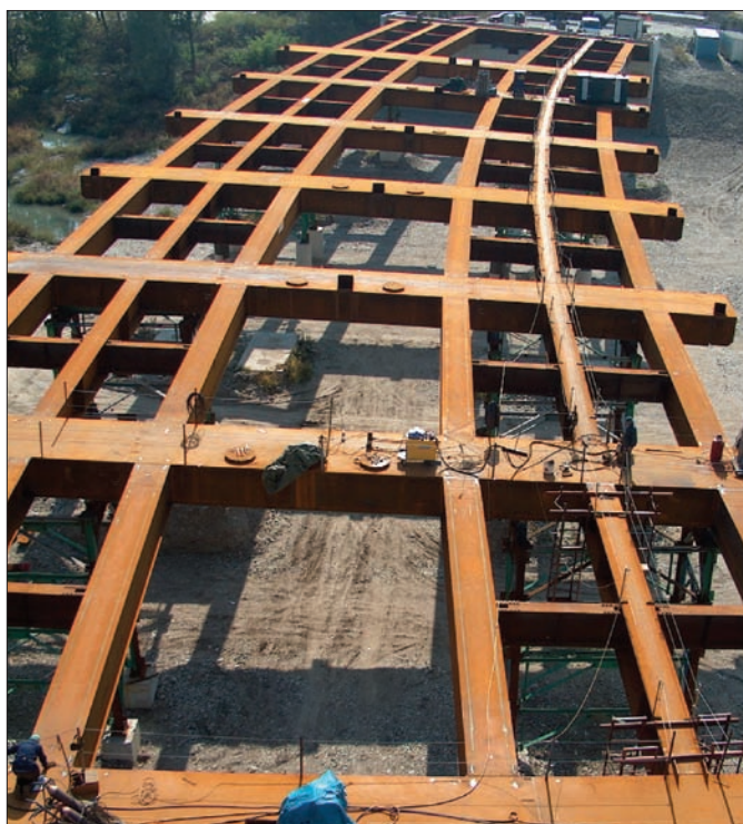
Fig. 4 - Assemblaggio delle travi di impalcato (foto Luca Piola)
