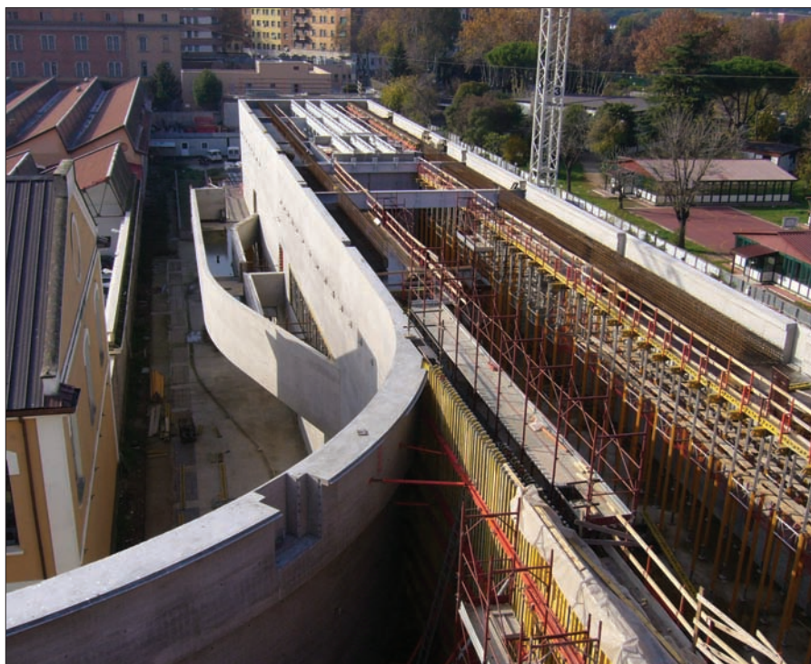
Fase di montaggio delle coperture della galleria 2, parallela a Via Masaccio
