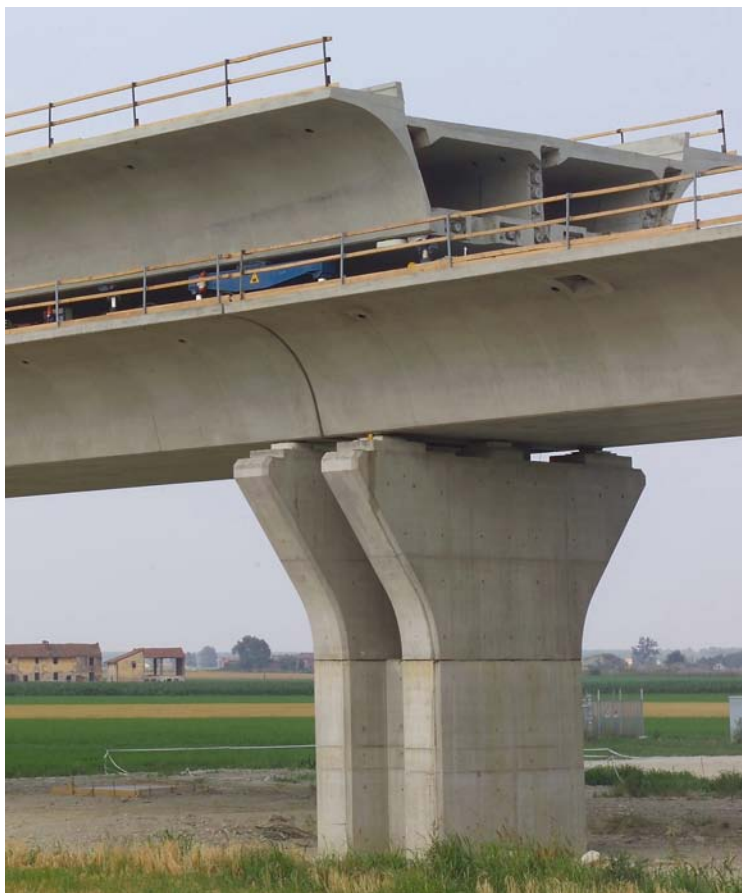
Fig. 5 - Viadotto Piacenza: fasi di trasporto di un cassone su rotaie provvisorie
