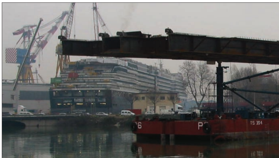
Fig. 12 - La parte metallica dell'impalcato durante il trasporto verso il ponte
