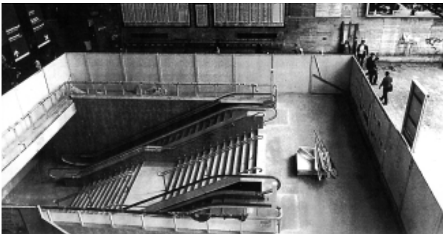
Una veduta del cantiere durante i lavori
