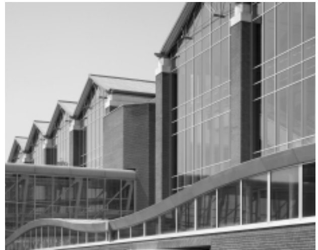
Avancorpo facciata Air Side: spigolo nord-est
