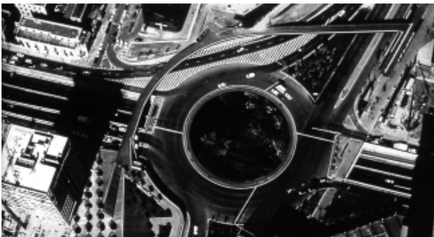
Barcelona. Plaza Cerdà, attacco a terra della passerella pedonale sui due lati della ronda del mig. Progettisti: Bernardo de Sola, Adolfo Monclus
