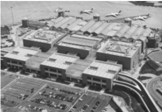
Foto aerea del cantiere
