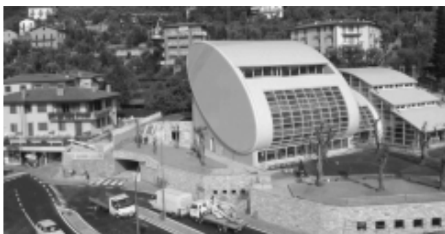
Stazione di valle
