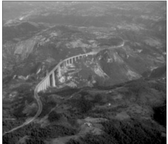
Autostrada Salerno-Reggio Calabria - viadotto Costaviola; Riccardo Morandi, 1970-72
