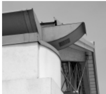
Sommità del pilastro e gronda in rame
