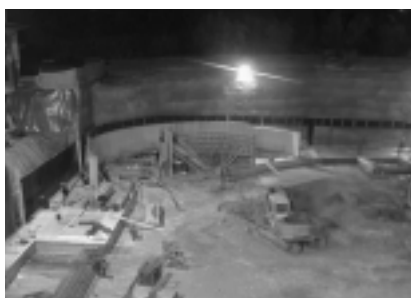
Parcheggio interrato in costruzione
