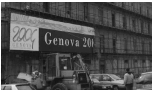
Lavori di ristrutturazione all'antica darsena comunale del porto antico. La darsena diventerà polo museale nel 2004, anno in cui Genova sarà capitale europea della cultura.
