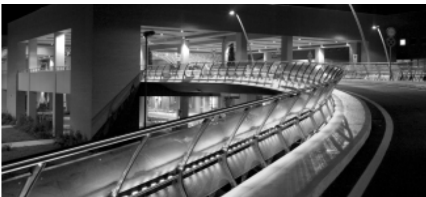
Rampa di accesso, viabilità a doppio livello
