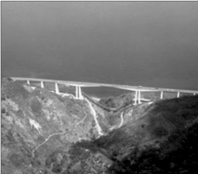
Autostrada Salerno-Reggio Calabria Viadotto; Carlo Cestelli Guidi e Fabrizio De Miranda, 1972
