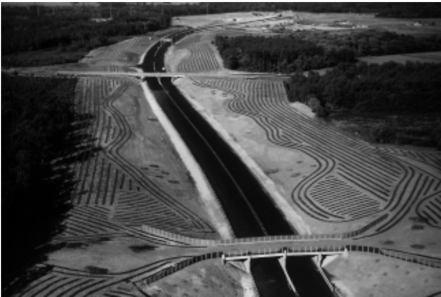
Autostrada A. 85 Angers / Tours, movimenti di terra e piantumazione di una frazione non lontana da Corzé. Progettista: Bernard Lassus
