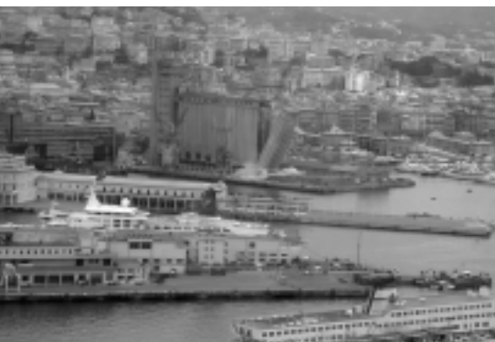
Demolizione del silo di Ponte Parodi
