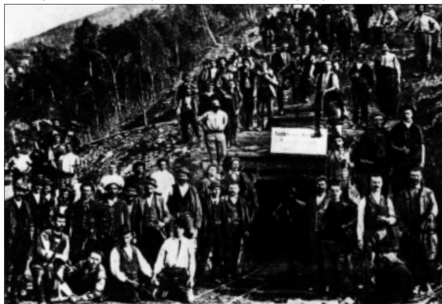
I lavori per il traforo del Sempione sul versante svizzero (1898)
