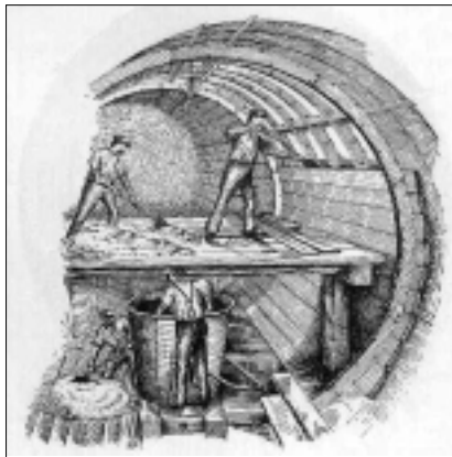
Esempio di costruzione manuale del rivestimento (da Legouéz)
