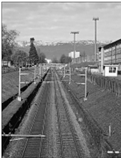
I binari prima della copertura
