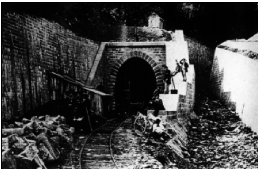
Testata nord della Galleria del Signorino (ml. 1073,29) in via di completamento.
