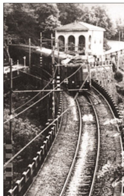
Viadotto delle Svolte: il treno 8023 in uscita dalla galleria Borrina attraversa la strada Porrettana.
