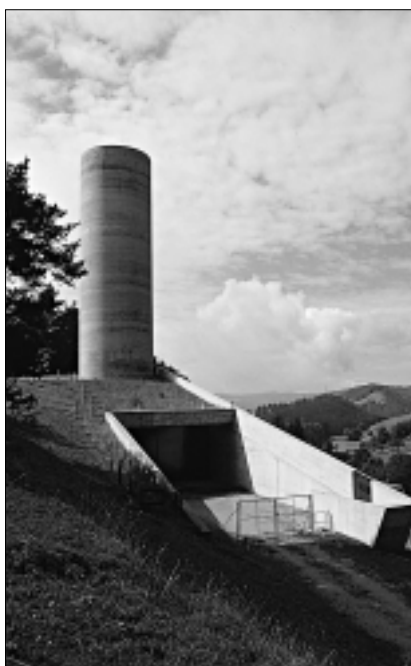
Flora Ruchat Roncati, camini di espulsione dell'aria lungo l'autostrada Transjurane
