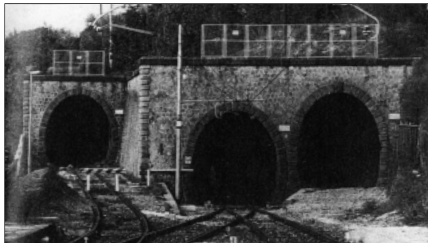
Corbezzoli, al centro la testa nord della galleria di Casciano, ai lati le gallerie dei binari di sicurezza e di lancio (a destra)
