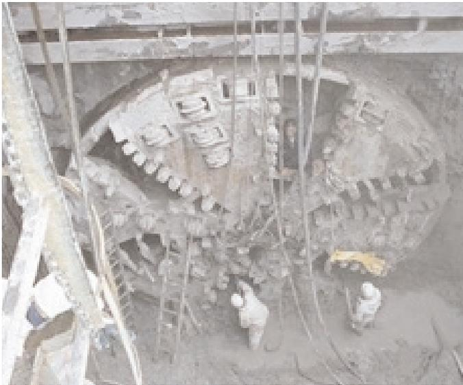
**Testa fresante della "talpa", TBM (Tunnel Boring Machine) utilizzata per lo scavo delle gallerie in presenza d'acqua di falda.**
