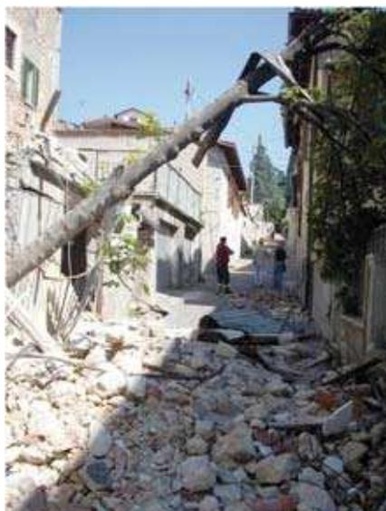
Fig. 5 - Interruzione dovuta al crollo totale di un edificio
