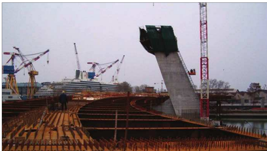
Fig. 13 - L'estradosso dell'impalcato prima del getto della soletta collaborante
