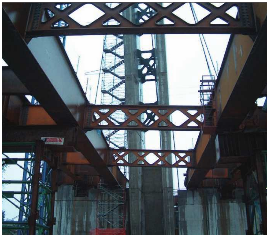
Fig. 6 - Retroponte e traversi di collegamento (foto Luca Piola)
