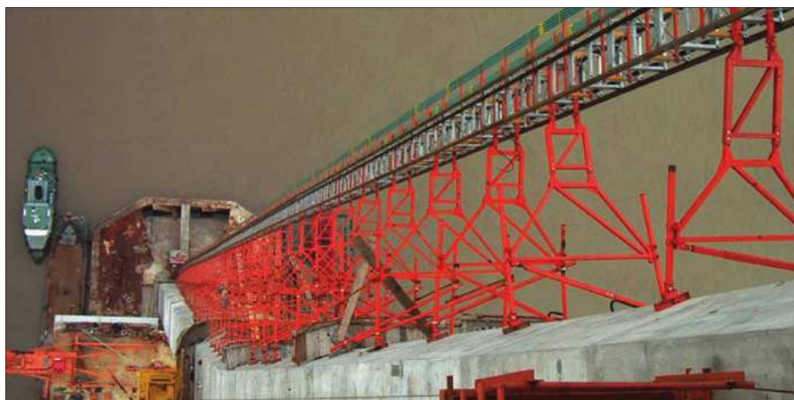
Fig. 10 - Vista delle fondazioni con le zone deputate all'assorbimento di eventuali urti con navi
