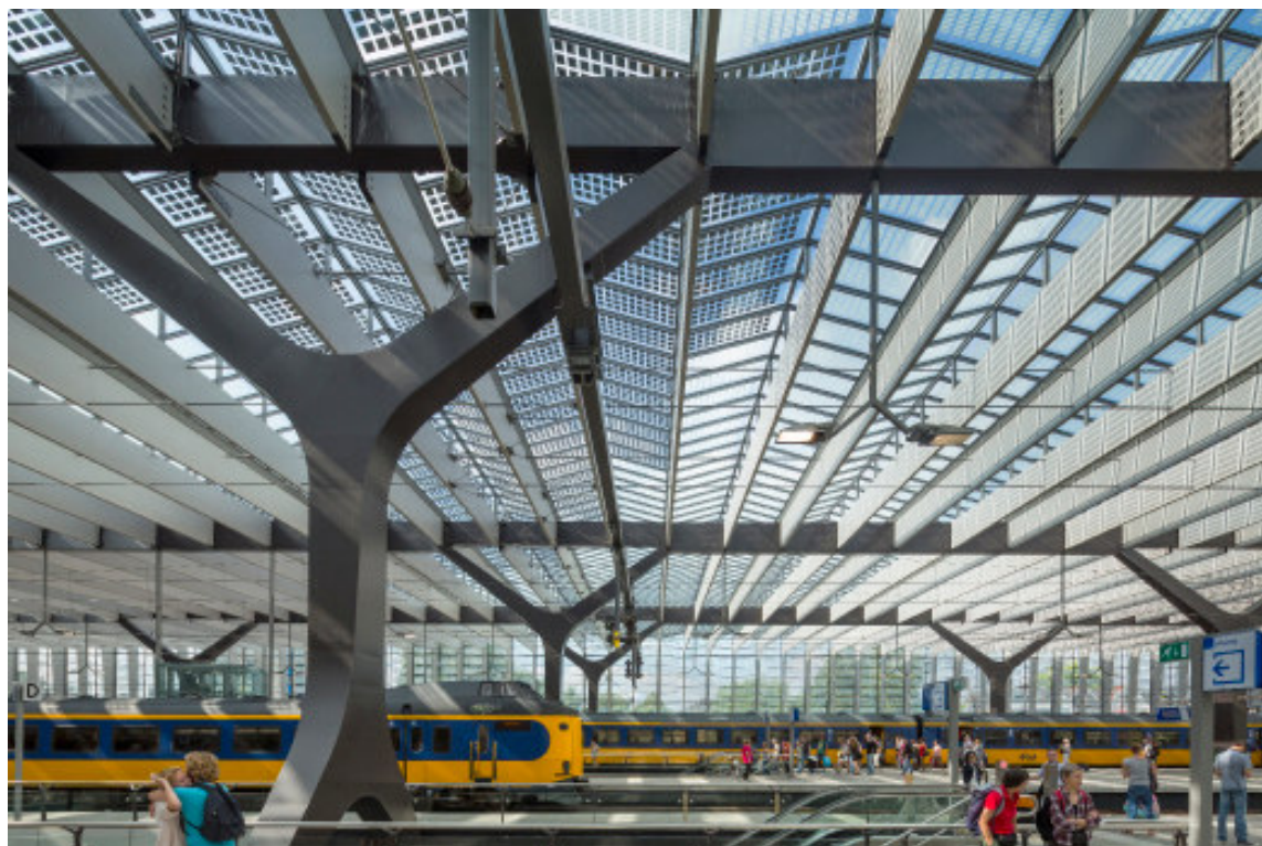
8 - Rotterdam Centraal, colonne a Y (Copyright Team CS, fotografia di Jannes Linders, 2013).
