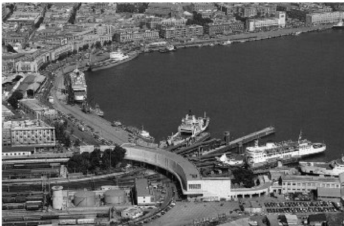
4 - Foto aerea del complesso della stazione.
