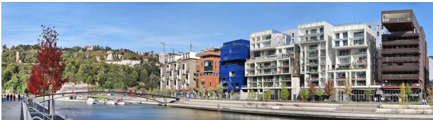
7 - Lyon Confluence, fasi di realizzazione del progetto.
