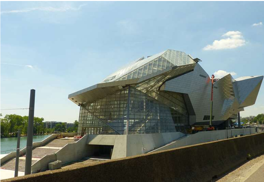
3 - Lyon Confluence, bacino, viadotto e le nuove costruzioni.
