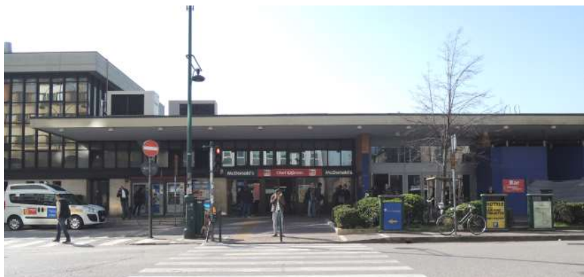
5 - Esterno della stazione di Venezia Mestre.
