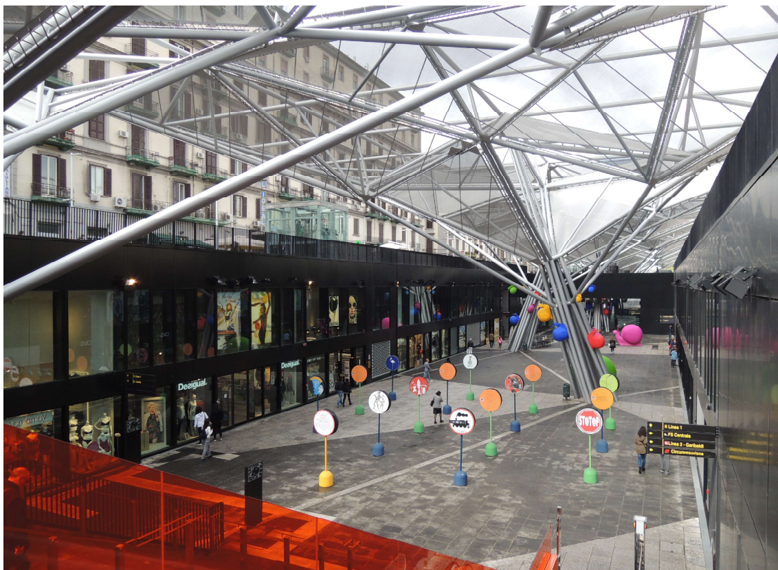
12 - Napoli, Piazza Garibaldi, accesso alla metropolitana. Foto di Laura Facchinelli.
