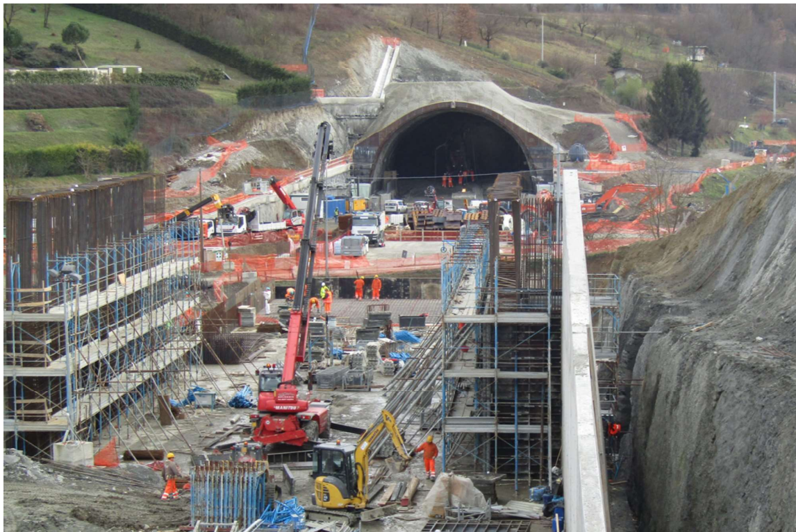
4 - Lavori di scavo e di messa in sicurezza delle opere infrastrutturali della linea ferroviaria "Terzo Valico".
