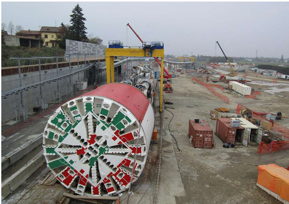
3 - Macchinario per lo scavo della "Galleria di Valico".
