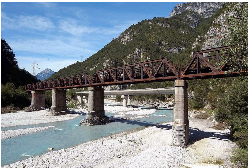
3 e 4 - Il viadotto di Ponteperaria in un'immagine del 1875 (in alto) e oggi (in basso).
